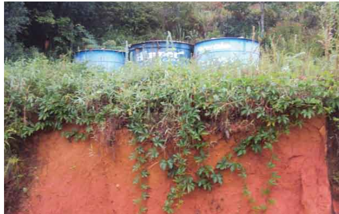
Caixas d'água com risco de desabamento
